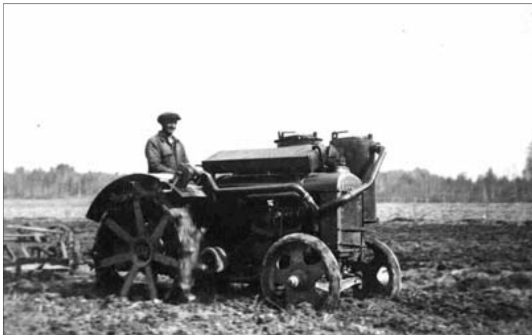
Ansion piikkipyörätraktori puukaasukäyttöiseksi muunnettuna 1940-luvulla (Kaija Schildtin kokoelmasta).
